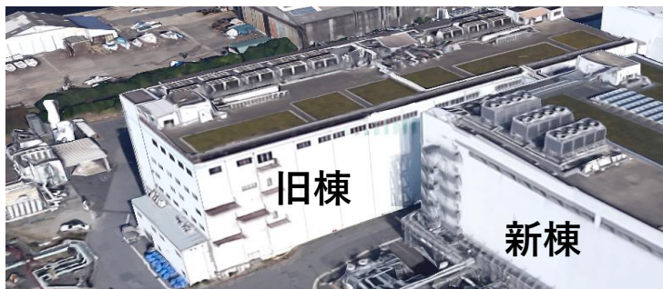
旧棟（研究開発棟）
